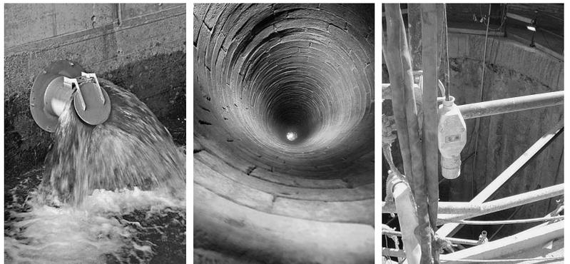
Der NIVA Niveauregler MS1 ist speziell zum Einsatz in Kläranlagen und Pumpstationen mit feststoffbelasteten Flüssigkeiten wie z.B. Roh-Abwasser geeignet. Dank der guten chemischen Eigenschaften sind unsere Niveauregler gegen Waschlaugen, Fäkalabwasser, Alkohole, Fruchtsäuren usw. sowie gegen viele schwach chemische / organische Emulsionen beständig bei einem Einsatz bis 80°C. Optional ist der Niveauregler MS1 mit Ex-Zulassung nach ATEX und IECEx erhältlich – siehe hierzu auch die nächste Seite.
