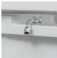
Funktionale plombierbare Berührschutzabdeckung
