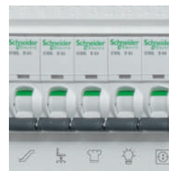
Das Stromkreisbezeichnungssystem ermöglicht eine eindeutige Beschriftung der Stromkreise.
