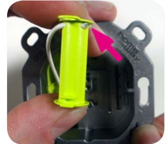
Abb.4: Einführen Kabel in Speicherspule
