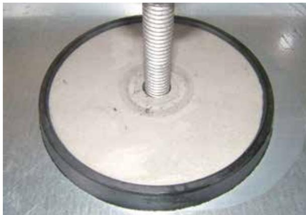
3. Positionierung der Konusdichtung und Verschraubung der Dichtmutter auf leichte Pressung. Anschließend Befestigung der Montageplatte mit zwei Kontermuttern und Anbindung der Tragkonstruktion
