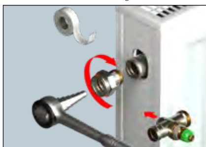
Der Anschlussnippel ist Bestandteil der RA-N Pressfit Ventile
