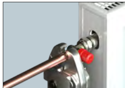
Achten Sie auf eine korrekte, mittige Platzierung des Ventils in der Pressbacke und verpressen Sie es. Verwenden Sie keine ölhaltigen Gleitmittel und achten Sie auf Sauberkeit innerhalb des Pressbereichs.
