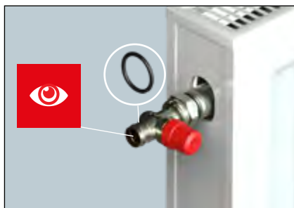
Bei der rohrseitigen Anbindung ist darauf zu achten, dass der O-Ring im Ventil richtig sitzt.
