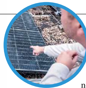
Ingolstadt: PV und Erneuerbare Energien im Fokus.
