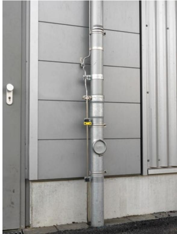
Blitzschutzableitung an einem Regenfallrohr
