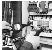
Spannungsfreiheit feststellen
