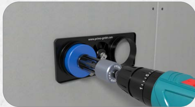
3. Für Mehrfachkombinationen Bohrschablone (P102-74) ins erste Loch einsetzen. Mithilfe der integrierten Wasserwaage ausrichten und den Hebel festspannen. Durch Versetzen der Schablone beliebig viele weitere Löcher im genormten Abstand von 71 mm bohren.
