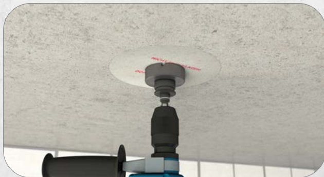
11. Alternativ: Universal-Frontteil für individuelle Ausschnitte. Verschiedene Öffnungen und Formen sind realisierbar.
