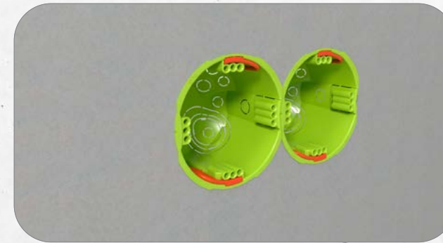
7. Dosen in die Bohrlöcher einsetzen und die Keile eindrücken.
