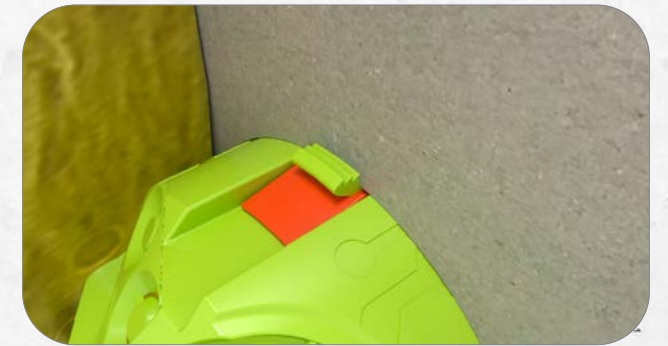
8. Klick-System: Durch das Einschieben der Keile wird die Dose in der Rigips-Platte fixiert.
