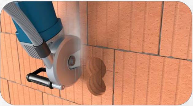
2. Schlitz mit Fräse bis in die Dosenbohrung fräsen. Anschließend leicht anfeuchten, damit Thermoschaum schneller aufquillt.
