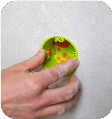
Hohlwandboxen der Q-Serie mit einem Durchmesser von 74 mm einstecken und befestigen.
