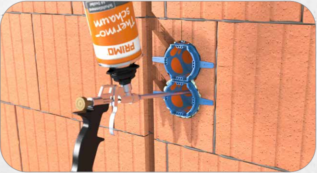
4. Dose einsetzen, Schaum (P717) einsprühen = in wenigen Sekunden wärmebrückenfrei und luftdicht installiert.
