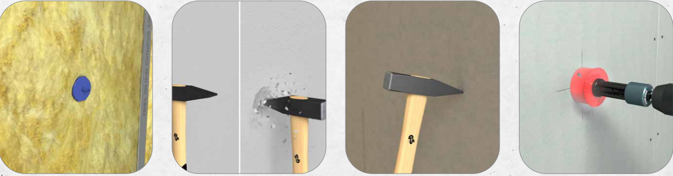
5. Dämmwolle einbringen. 6. Option 1: Gipskartonplatte anbringen und Spitze durchdrücken. 7. Option 2: Gipskartonplatte andrücken und mit einem Hammer ein Loch an der markierten Stelle einschlagen. Anschließend die Gipskartonplatte anbringen, sodass der Dorn durch das Loch sticht. 8. Loch ausfräsen. Der Dorn dient dabei als Zentrierbohrloch.
