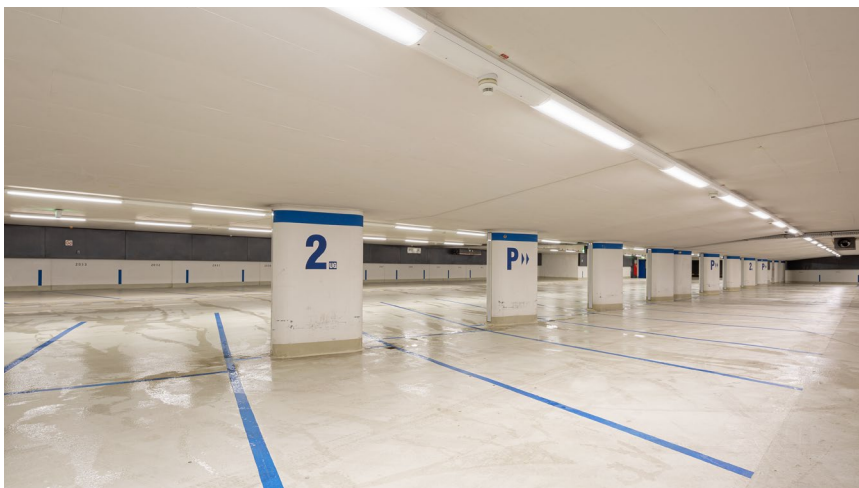
Parkhaus Am Theater, Frankfurt a.M. Baujahr: 2022 Themenbereich: Verkehrswege Fotograf: Frieder Blickle
